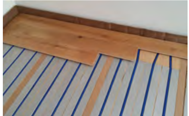
Verlegung von Massivholzdielen
