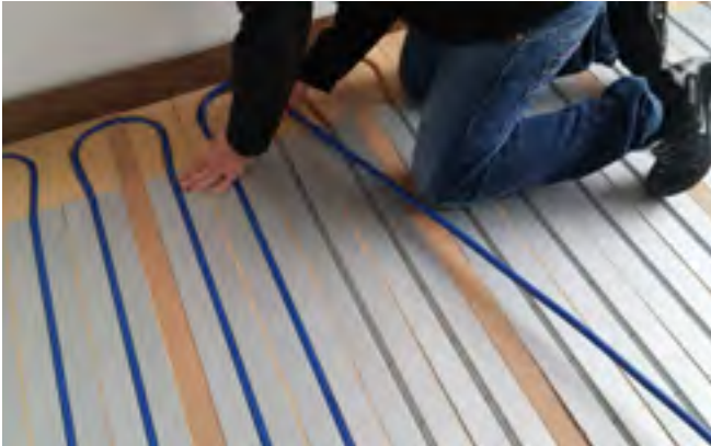
Randdämmungstreifen/ Verlegeplatten Heizungsrohre/ Polsterhölzer gem. Systemhersteller verlegen.
